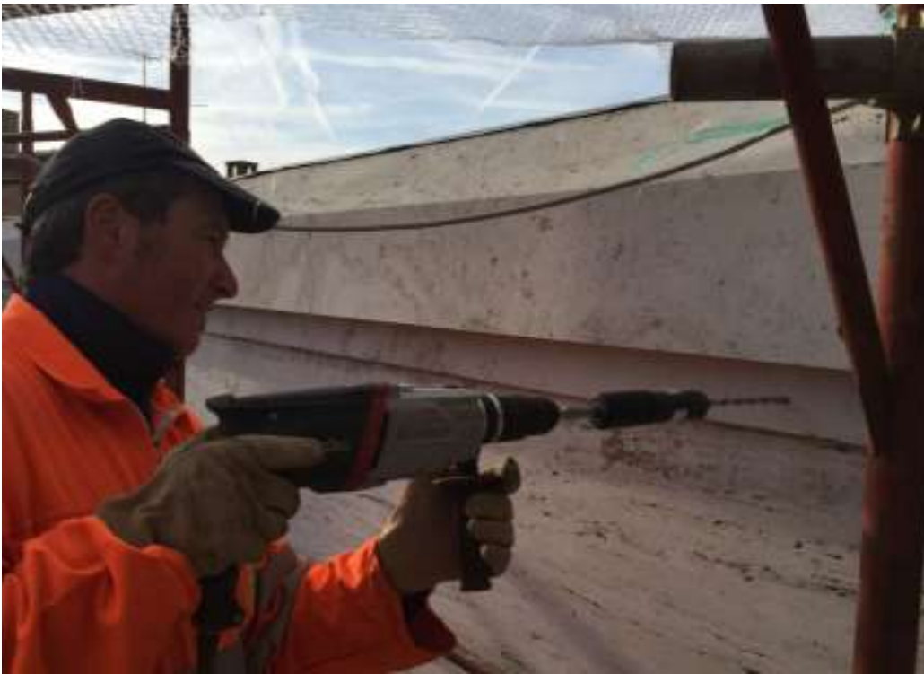
Installazione Steel DryFix
