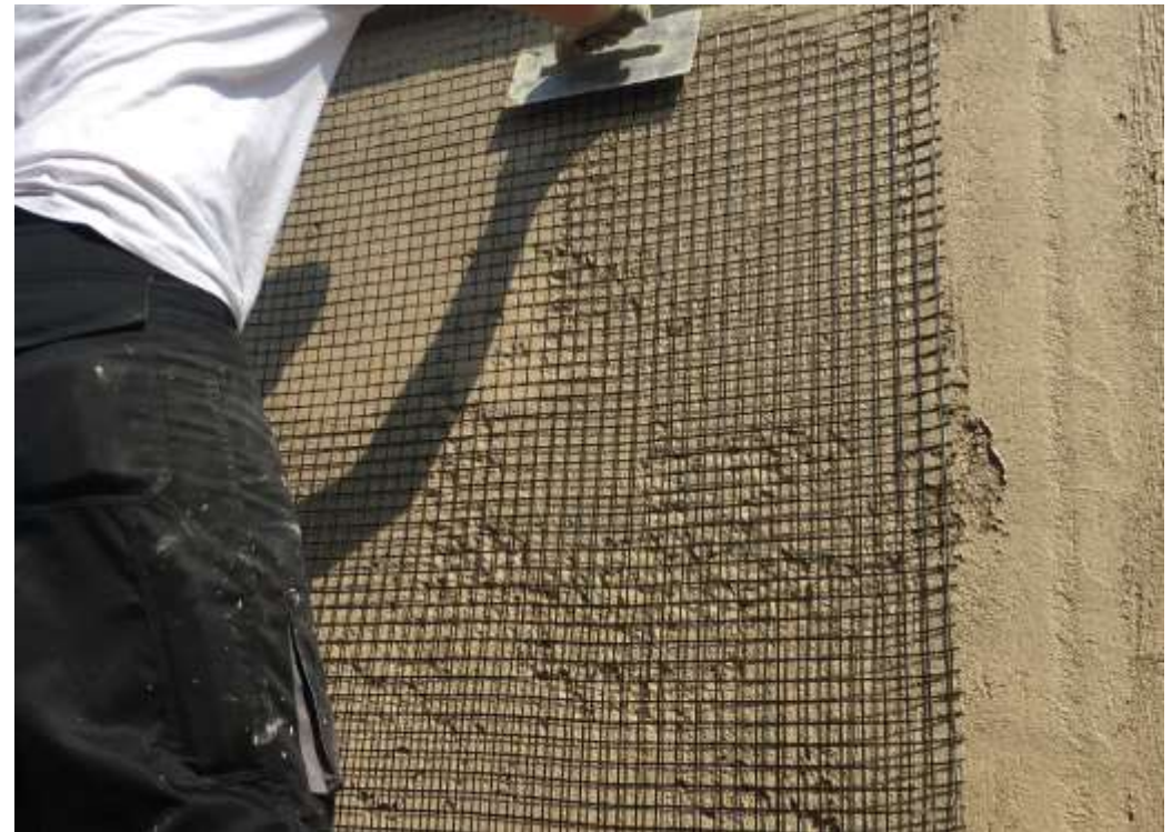
Stesura della rete GeoGrid 120
