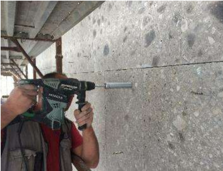
Installazione Steel DryFix
