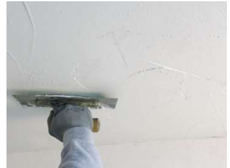
Applicazione seconda mano GeoCalce Multiuso
