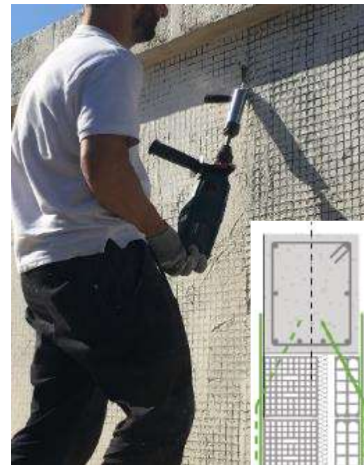
Installazione Steel DryFix
