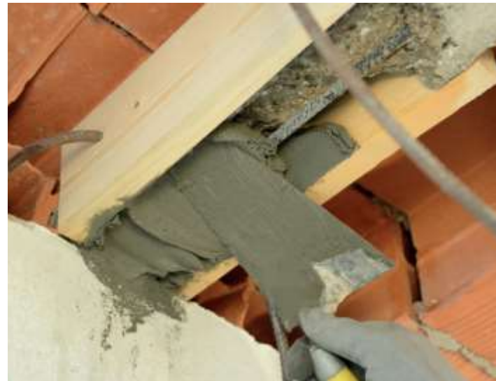
Ricostruzione travetto con GeoLite
