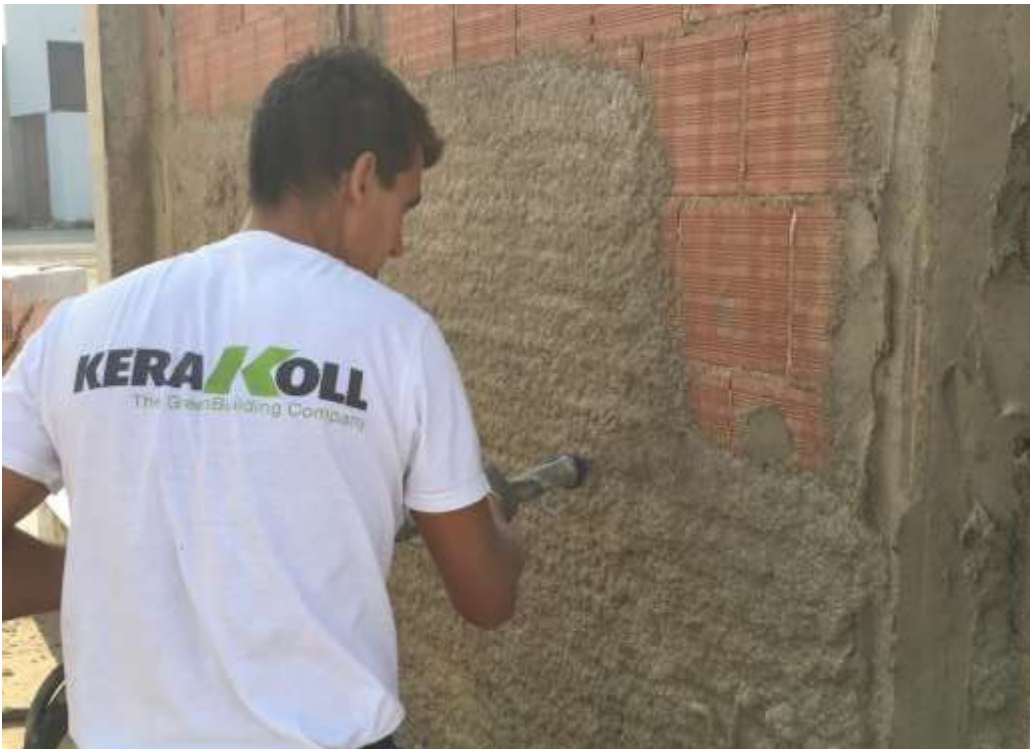
Applicazione primo strato di GeoCalce Tenace (circa 1 cm)
