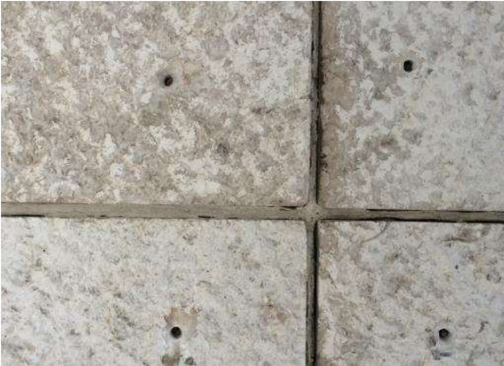
Realizzazione fori pilota
