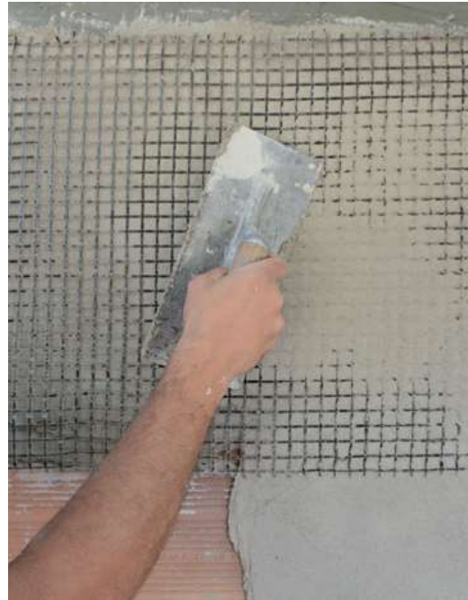
Installazione Geo Grid 120
