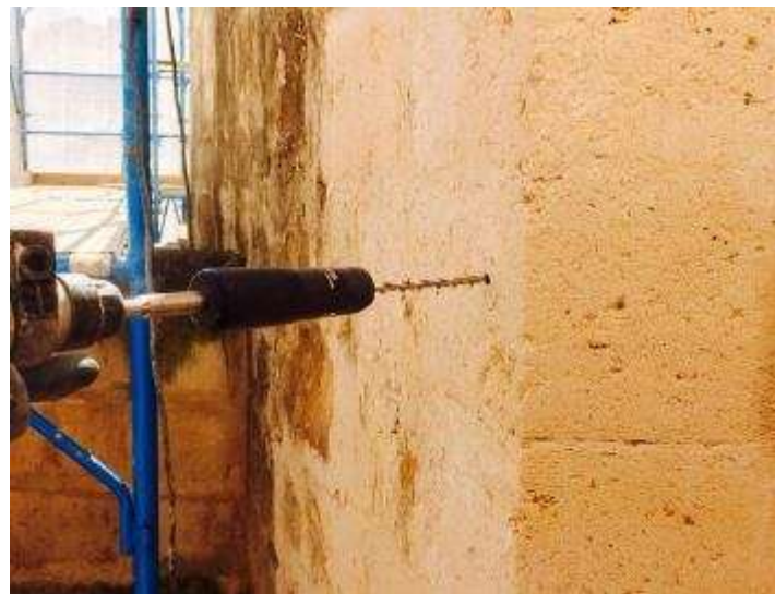
Installazione della barra con Mandrino Steel DryFix
