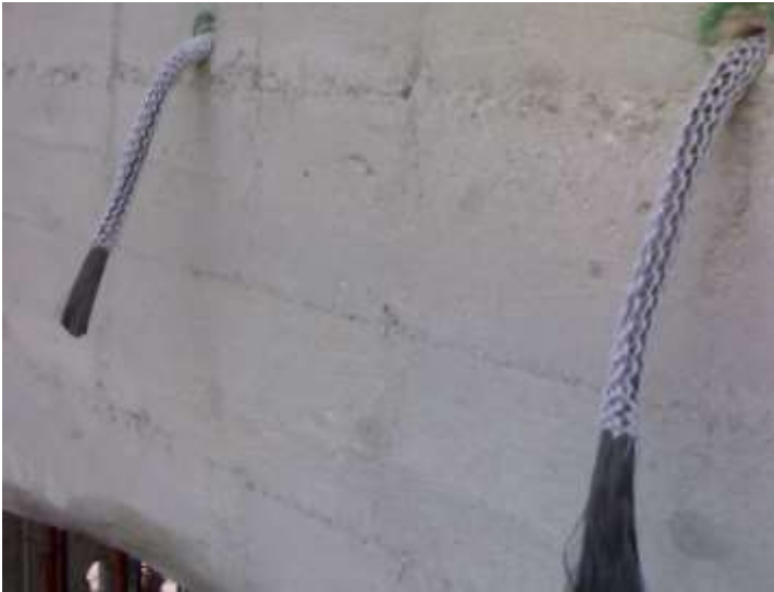
Ancoraggio discontinuo con fiocco carbonio FRP
