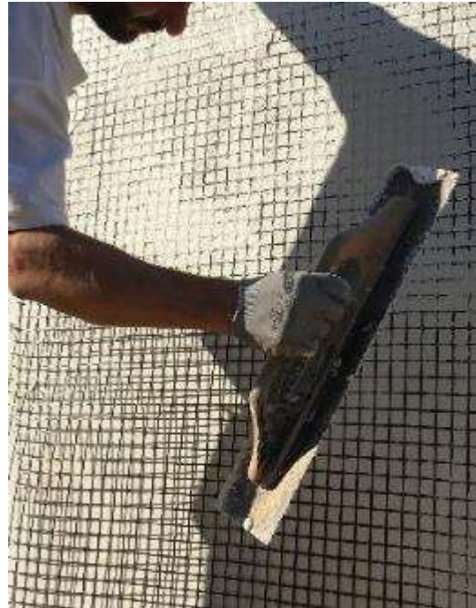
Installazione Geo Grid 120
