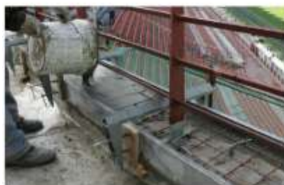
RIPRISTINO CORDOLI IN CLS
