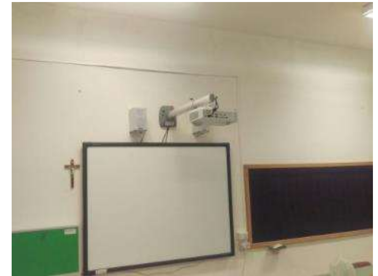
Parete rinforzata non danneggiata dal sisma
