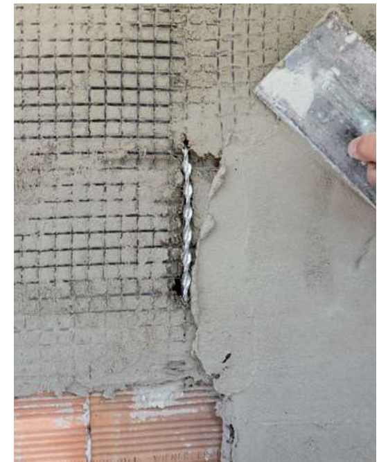
GeoCalce F Antisismico seconda mano
