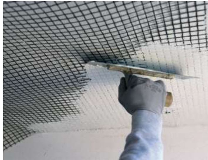
Installazione Geo Grid 120
