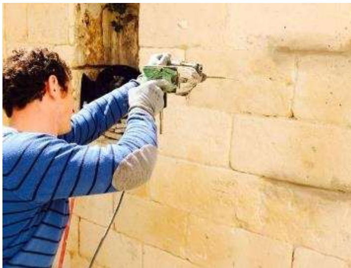
Realizzazione foro pilota di diametro inferiore
