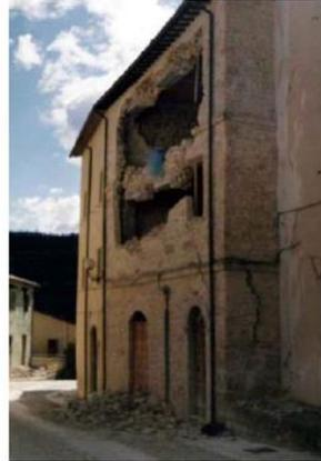
Fig. 1.2 – Meccanismi di flessione verticale
